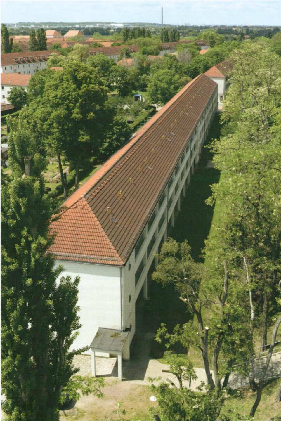
ABB. 3 Bad Dürrenberg, Thomas- Müntzer-Straße, Laubengang- haus in der Alexander-Klein- Siedlung
